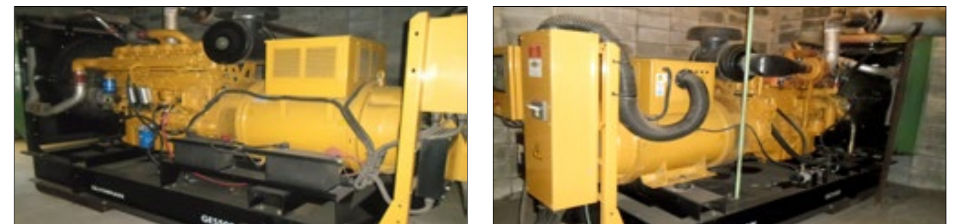
03 Geradores proporcionam total independência da rede elétrica pública. 03 Generators than can sustain power supply independently of the local power grid.
